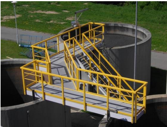
Abbildung 6: GFK-Betriebsbrücke in einer Kläranlage nach 20 Jahren Einsatz (Quelle: CTS Composite Technologie Systeme GmbH)
