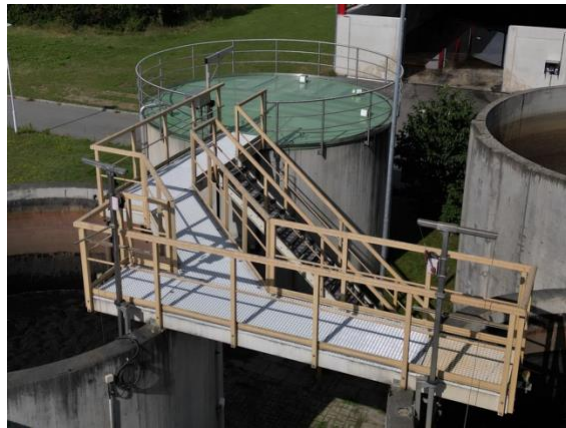
Abbildung 6: GFK-Betriebsbrücke in einer Kläranlage nach 20 Jahren Einsatz (Quelle: CTS Composite Technologie Systeme GmbH)
