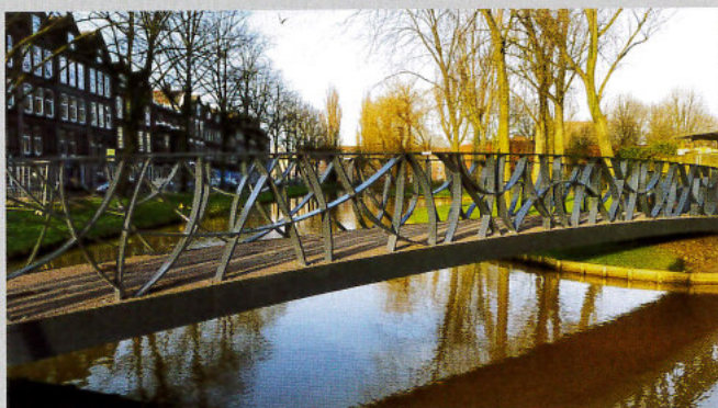
Grachten-Idylle in Rotterdam – mit Brücken aus Verbundkunststoffen
