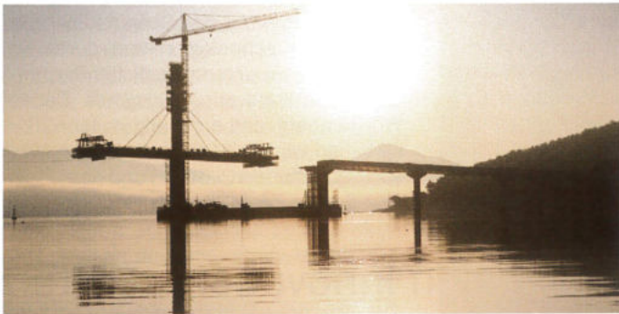
Abbildung 3: Neubau & Sanierung von Brücken – Composites können enorme Vorteile bringen
