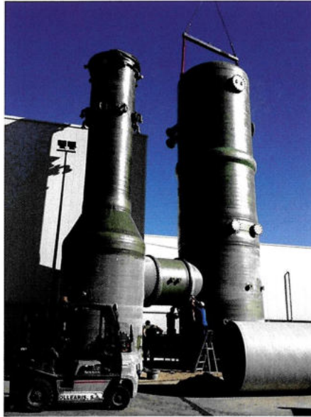
Abbildung 1: Quench und Scrubber (links) und installiertes System (Quelle: AOC/ Olllearis)
