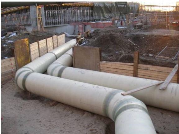
Abb. 1: GFK im Rohrleitungsbau - Seit mehr als 50 Jahren eine Alternative (Quelle: Amiantit)
