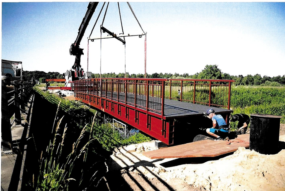
Abbildung 3: Der Brückenbau zählt zu den wichtigsten Einsatzgebieten von pultrudierten Profilen (Quelle: EPTA)
